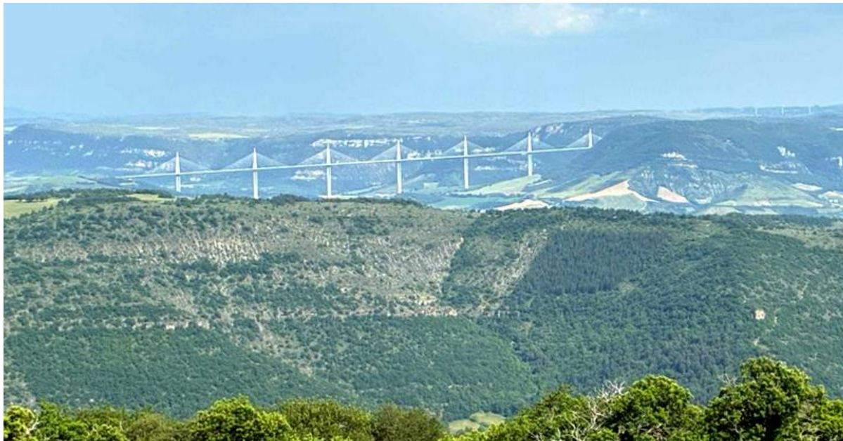
Le viaduc de Millau
